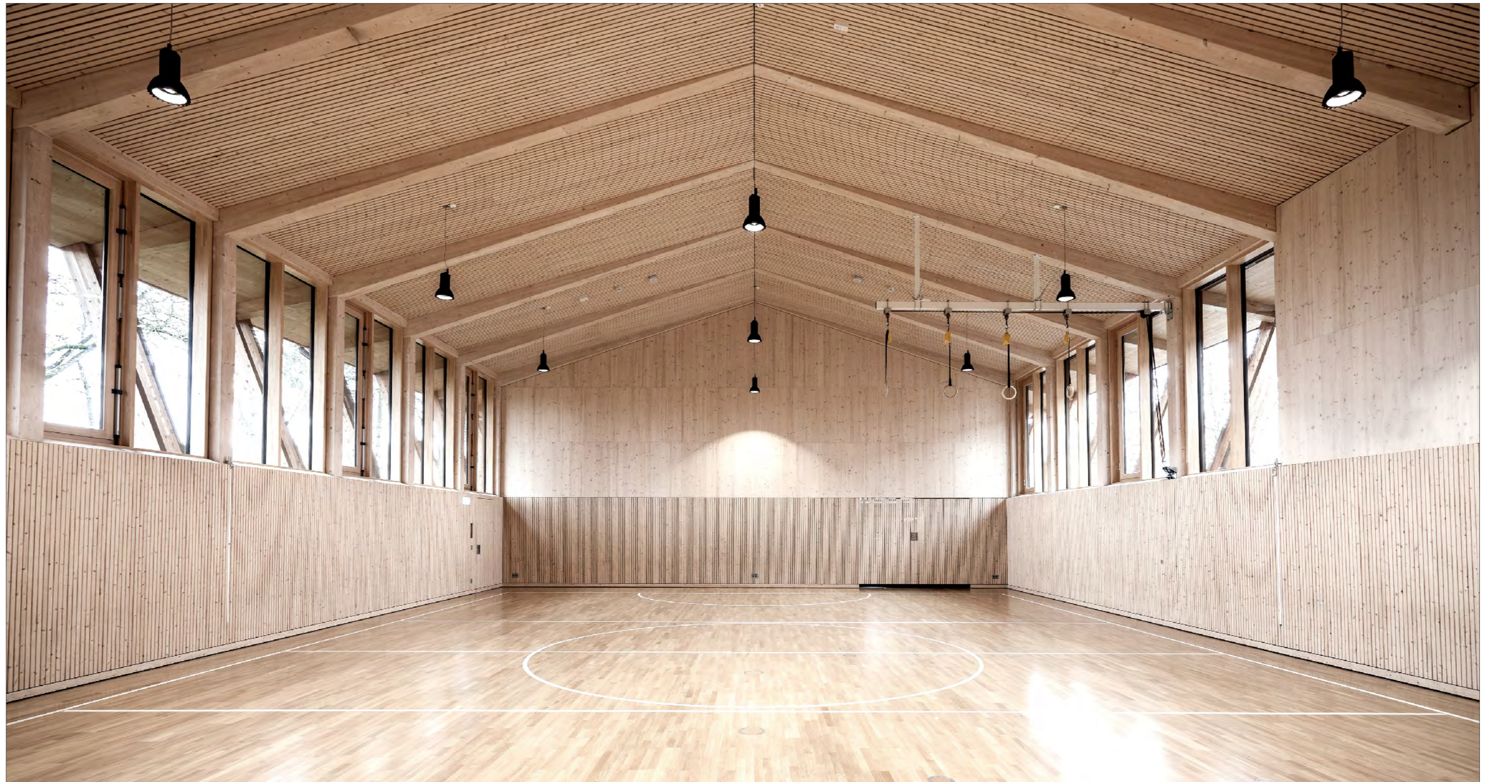
Generalsanierung Dreifachturnhalle Fürstenstein Gemeinderatssitzung 26.03.2026 Beispielbild Turnhalle
