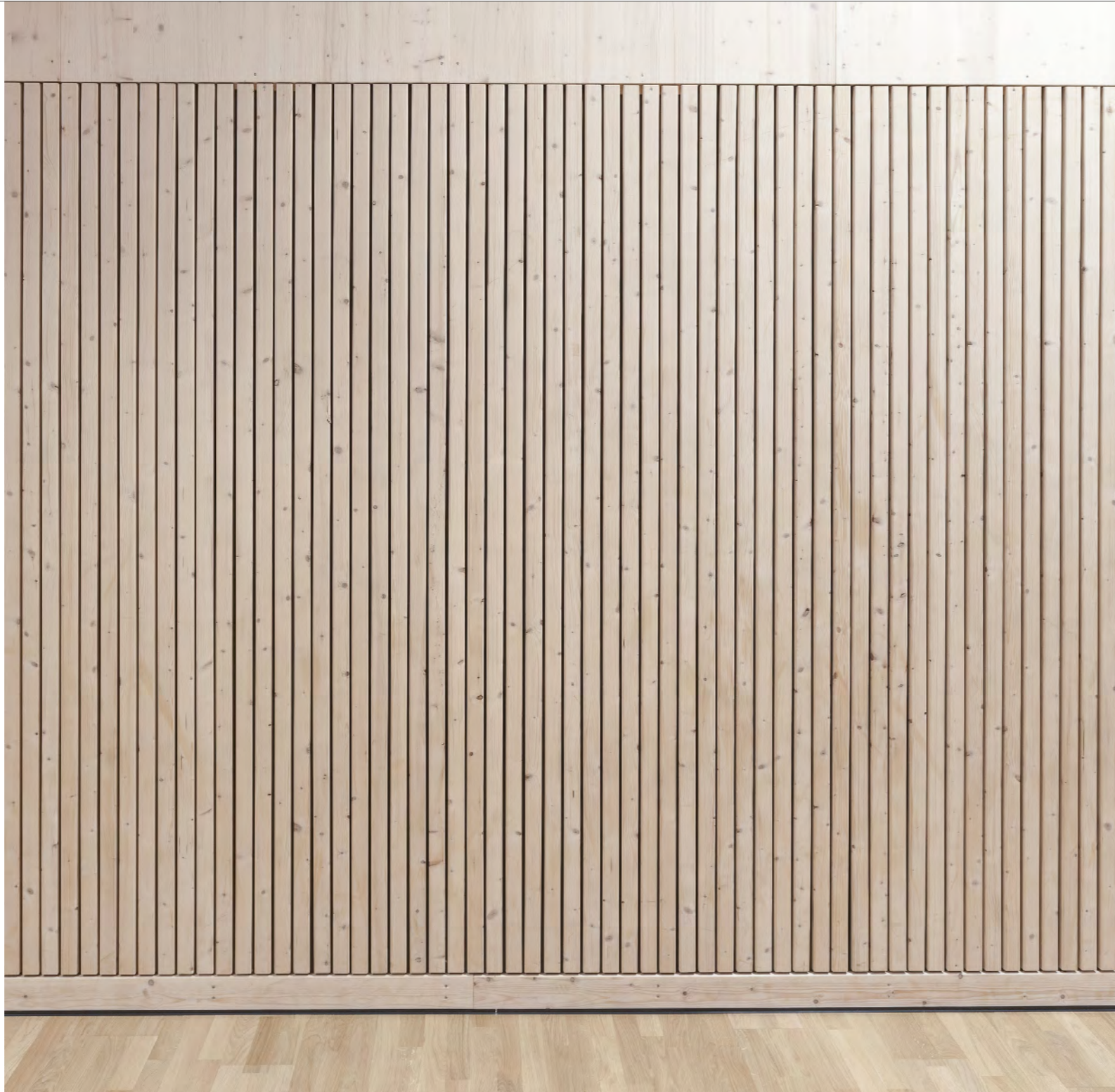
Generalsanierung Dreifachturnhalle Fürstenstein Gemeinderatssitzung 26.03.2026 Beispielbild Turnhalle
